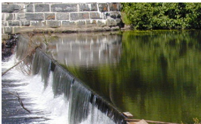
Une prise d'eau potable de la région de Québec. Photo: Manuel Rodriguez, 2020
