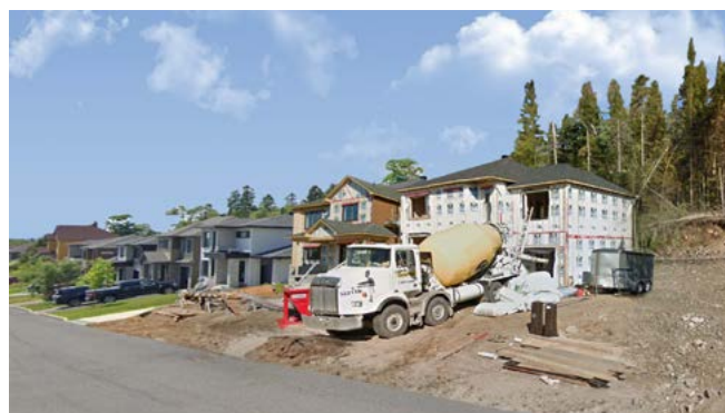
438, rue des Autochtones à Québec. Montage photo : Émilie Béland et Cédrik McKenzie. Source : Google StreetView
